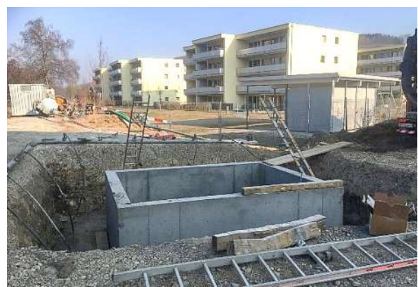
Einbau vorfabrizierte Betonschachtelemente
