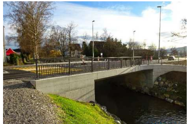
Neue Bünzbrücke bei der Nutzenbachstrasse
