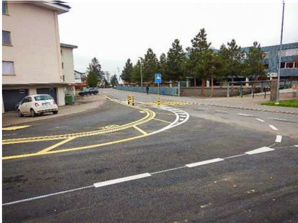
Fussgängerquerung Sorenbühlweg mit neuer Markierung
