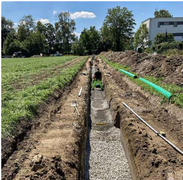
Graben für die Verlegung neue Drainagesammelleitung
