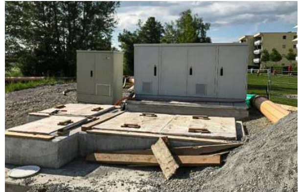
Schaltschränke für Pumpensteuerungen erstellt
