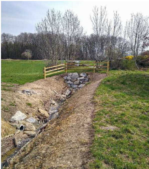
Ausgedolter Wohlerbergbach im obersten Abschnitt
