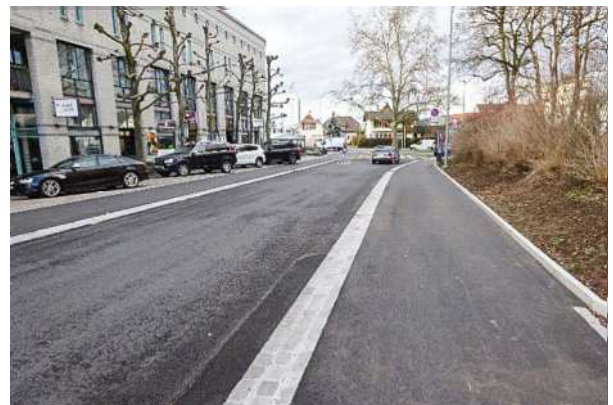
Aargauerstrasse nach Sanierung und Ausbau
