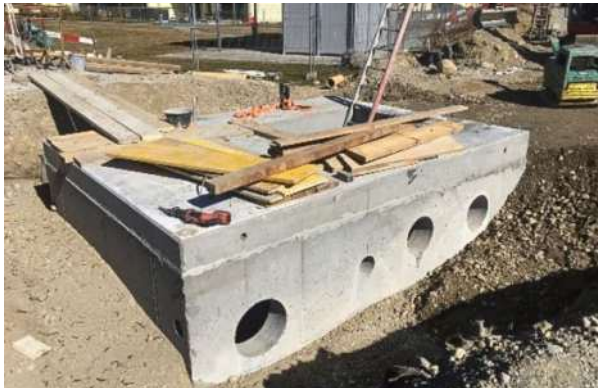
Kernbohrungen für Leitungsanschlüsse in Seitenwand
