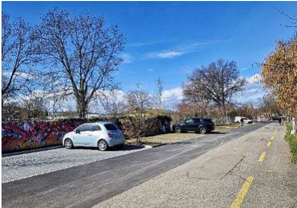
Neue Parkplätze mit Schotterrasen
