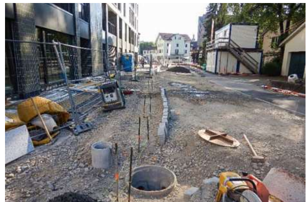
Einbau neue Randabschlüsse und Entwässerungsschacht
