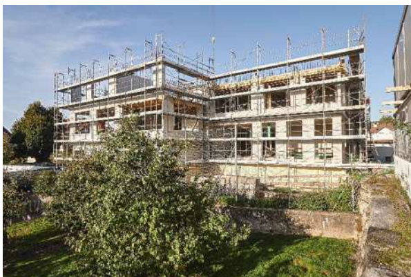
Neues Primarschulhaus Halde im Rohbau
