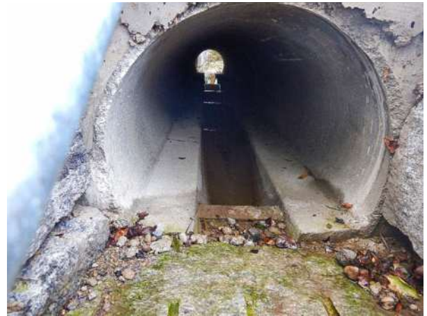
Neuer Bachdurchlass Guggibach unter der Steingasse
