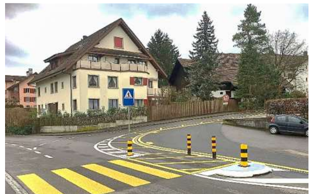
Fussgängerquerung Sorenbühlweg mit Schutzinsel und Warte- raum
