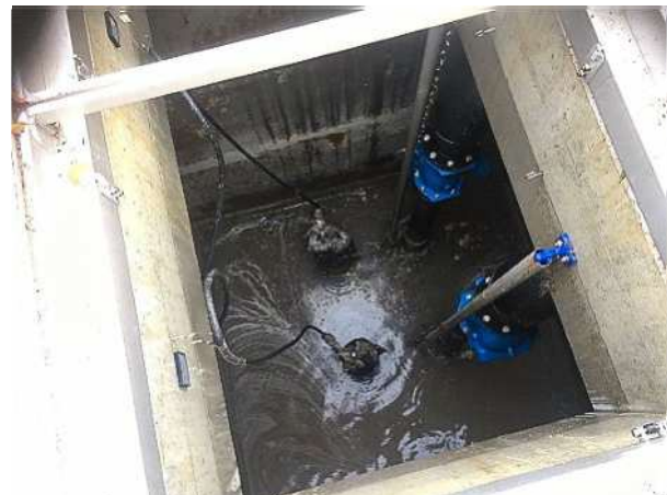
Tauchpumpen und Ableitungen eingebaut
