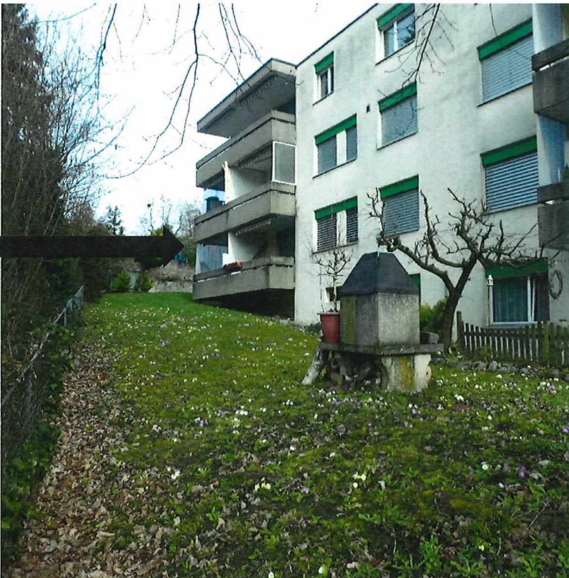
Abb. 12 Wohnung Pfeil Blick auf Wohnung im Erdgeschoss
