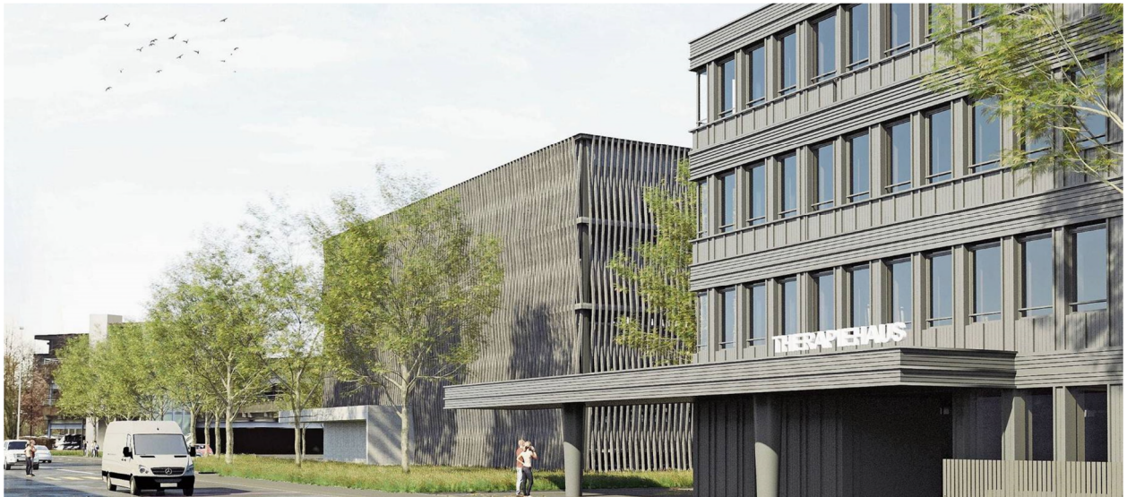
Abbildung 18 Neubauprojekt Parkhaus KSA, Frei Architekten, Aarau
