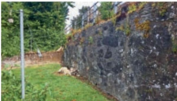
Teileingestürzte Bruchsteinmauer bei der Schulanlage Halde
